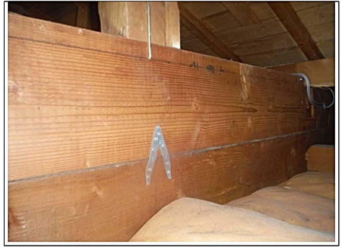
梁継金物確認 カスガイ金物確認
