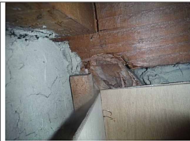
筋交い確認 土壁確認
