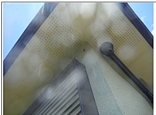
軒裏換気板確認
